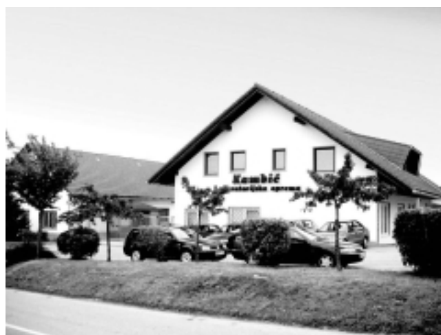
Slika 2: Proizvodni in upravni zgradbi podjetja Kambič – Laboratorijska oprema
